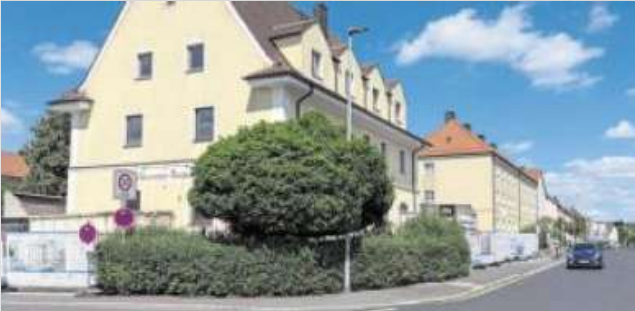
An dieser Stelle entsteht der Neubau-Komplex mit 13 Wohnungen. Bild: Petra Hartl
