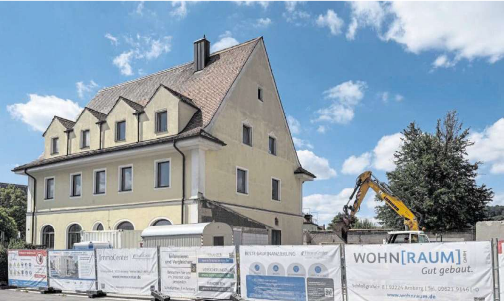
Die Bagger sind schon angerückt. Ab Montag ist der Abriss der Mosacher Stubn geplant.
